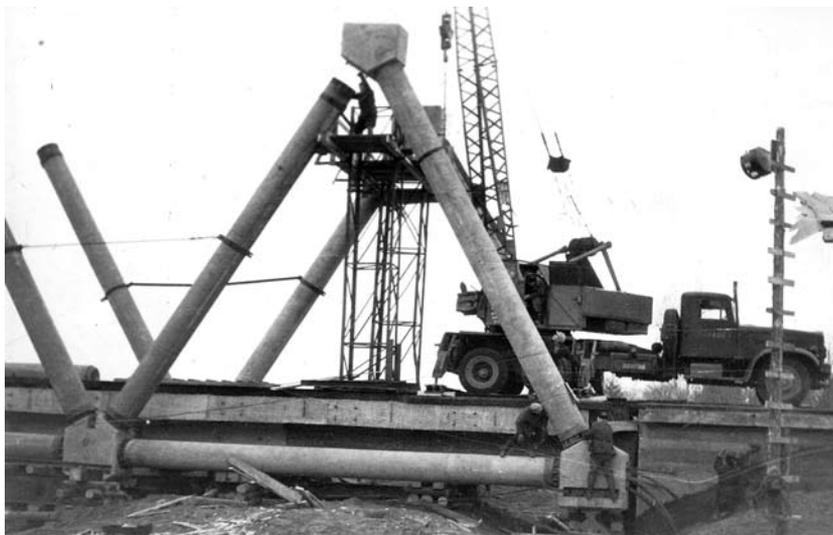
Рис. 6. Монтаж решетки фермы
