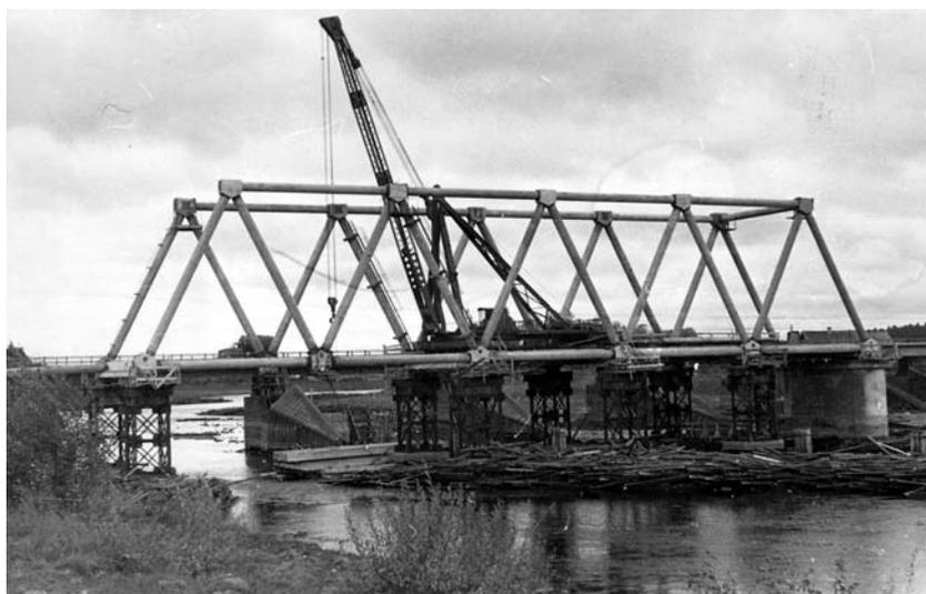
Рис. 11. Монтаж двух моделей внавес
