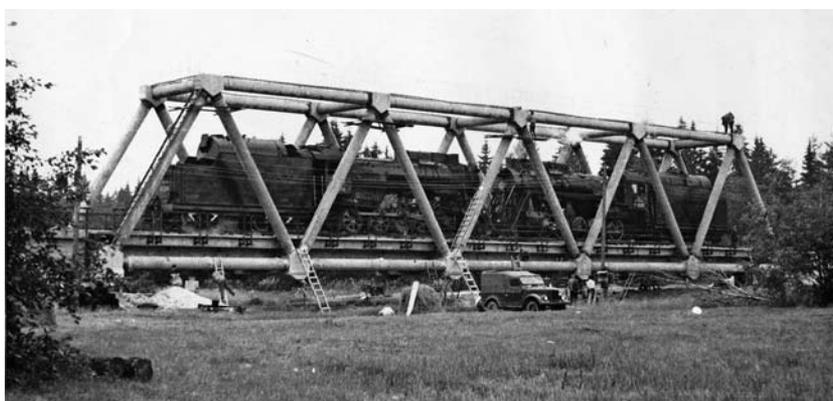
Рис. 7. Испытание железнодорожной фермы
