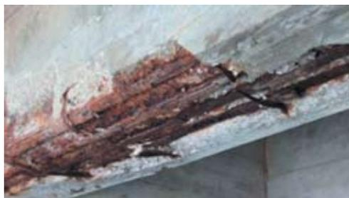
Рис. 2. Коррозия арматуры в нижней зоне балки
