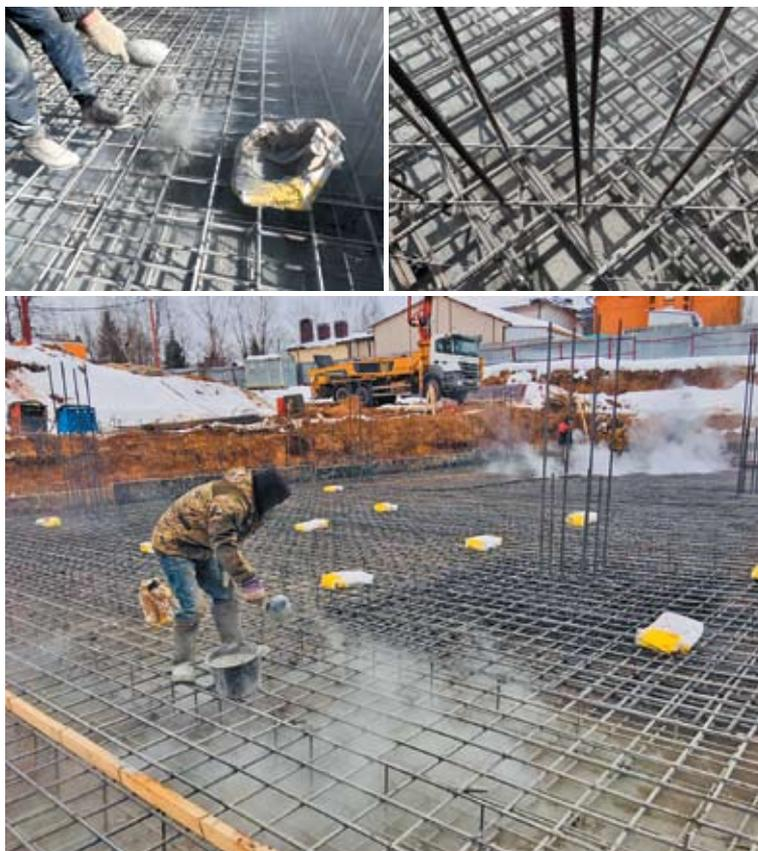
Рис. 1. Выполнение гидроизоляции методом «просыпки»
