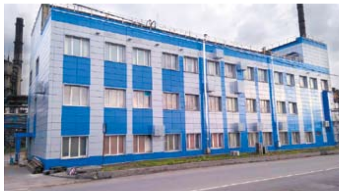
Здание коксохимической лаборатории ПАО «Северсталь», облицованное фасадными кассетами из стали с покрытием SeverFarm
