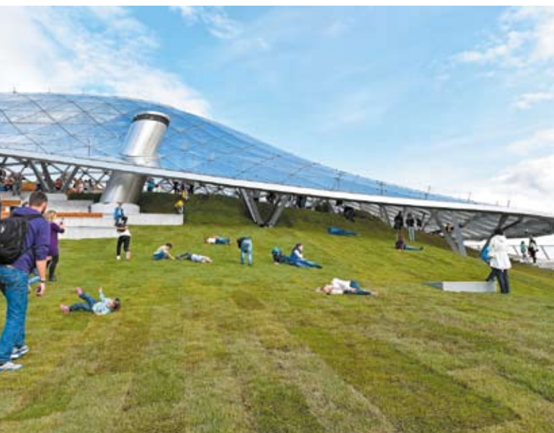
Инверсионная зеленая кровля с применением теплоизоляции ПЕНОПЛЭКС® на крыше концертного зала парка «Зарядье», г. Москва. Фото с сайта stroi.mos.ru
