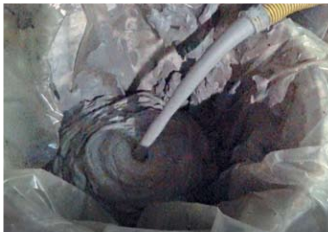
Рис. 10. Утепление сверхлегким пенобетоном (СЛПБ).
