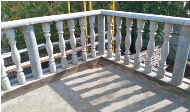
Рис. 7. Веранда 2-го этажа с ограждением ЖБ перилами и ЖБ балясинами.
