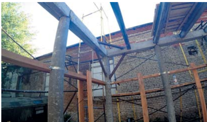
Рис. 6. Сборно-монолитный железобетонный каркас.
