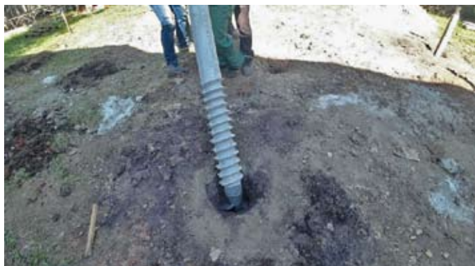
Рис. 2. Вкручивание железобетонных винтовых свай.
