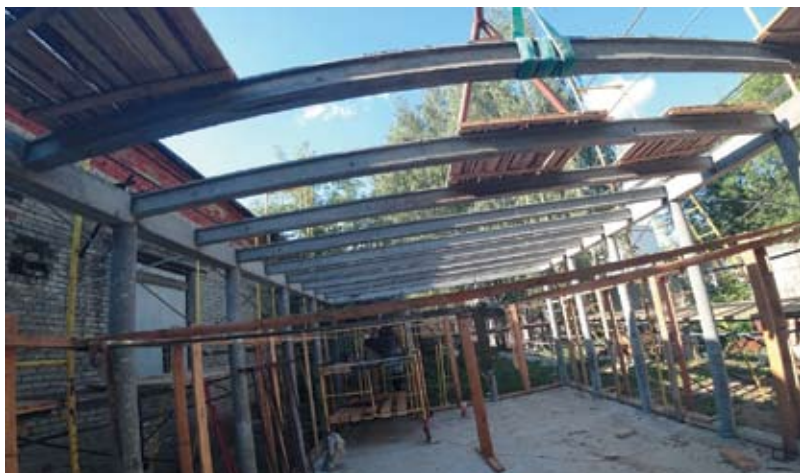
Рис. 5. Сборно-монолитный железобетонный каркас.
