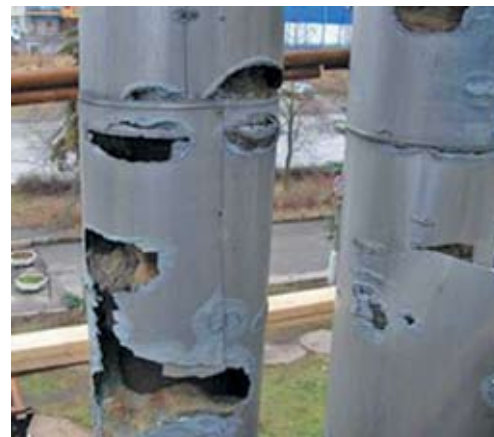
Рис. 1. Минеральная вата после 3-х лет эксплуатации
